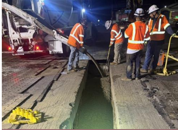
Trabajos para proteger las líneas de alcantarillado existentes en Panorama City.
