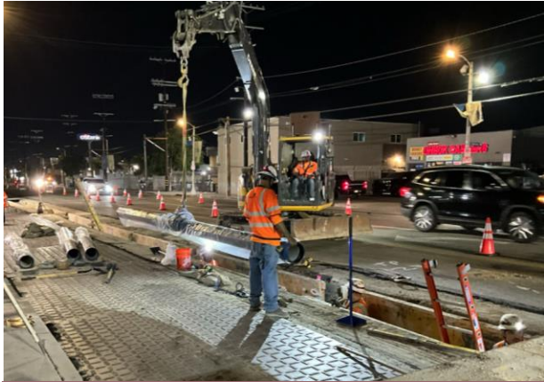
Trabajos de servicios públicos en Pacoima para la instalación de una tubería de agua.
