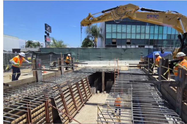
Cuadrillas de trabajo en Van Nuys realizando la reconstrucción del cajón de concreto del Arroyo Pacoima (Pacoima Wash).
