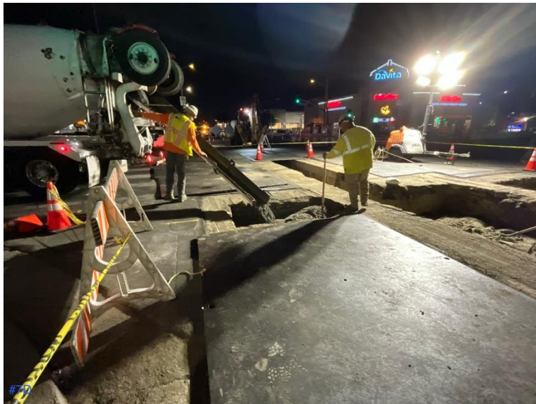
Excavación y zanjas en Van Nuys Bl cerca de Roscoe Bl para trabajo del gas en Sherman Way.
