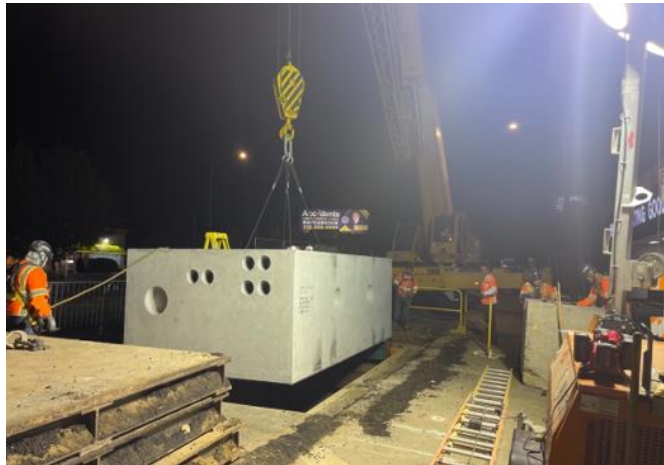
Instalación de bóvedas en Van Nuys Bl y Wyandotte St
