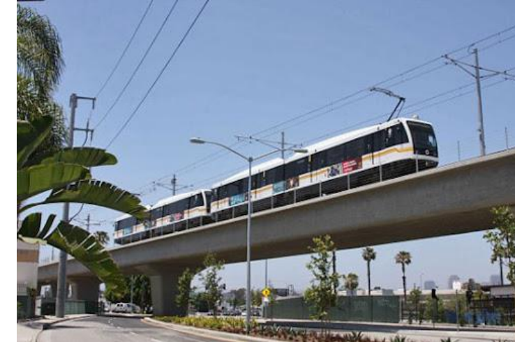
Estructura aérea (arriba de la calle)
