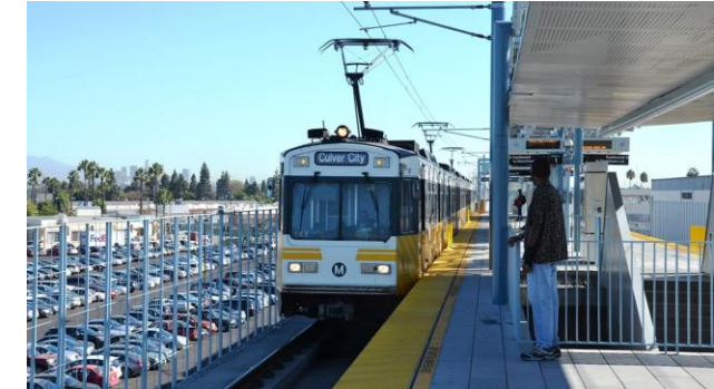
Instalaciones de estacionamiento
