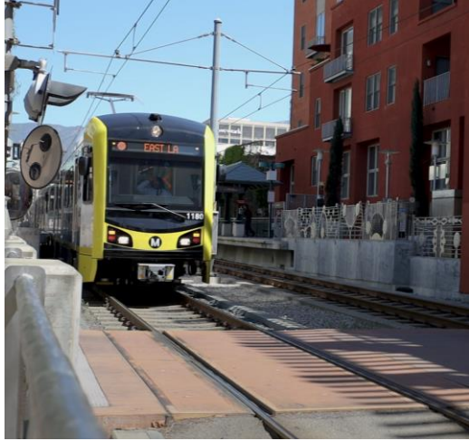
Postes del sistema catenarío aéreo
