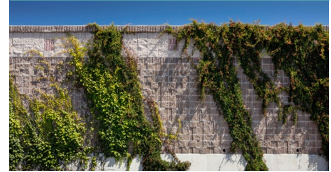
Mejoras en los muros acústicos
