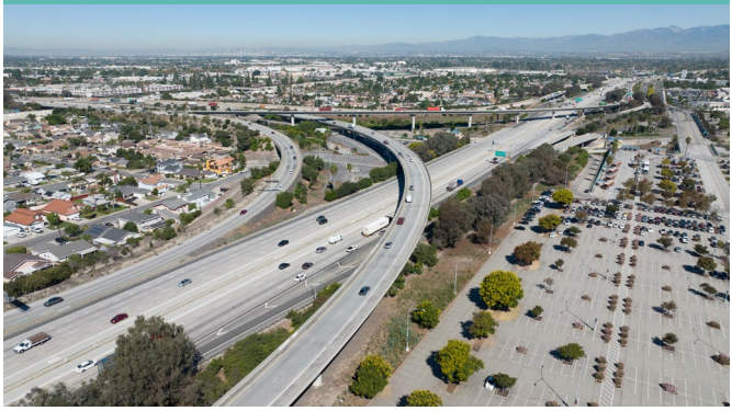
Mejoras en los intercambiadores
