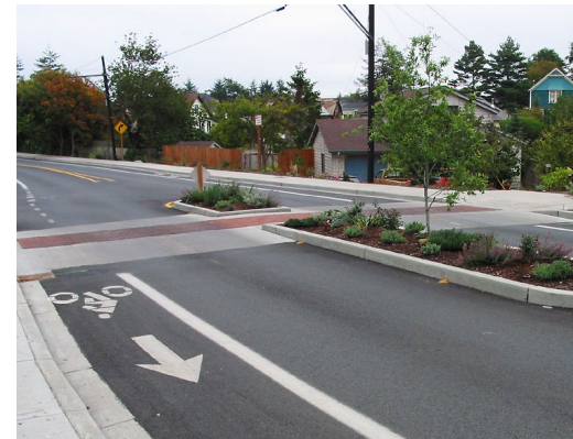
Terraplén elevado y cruce
