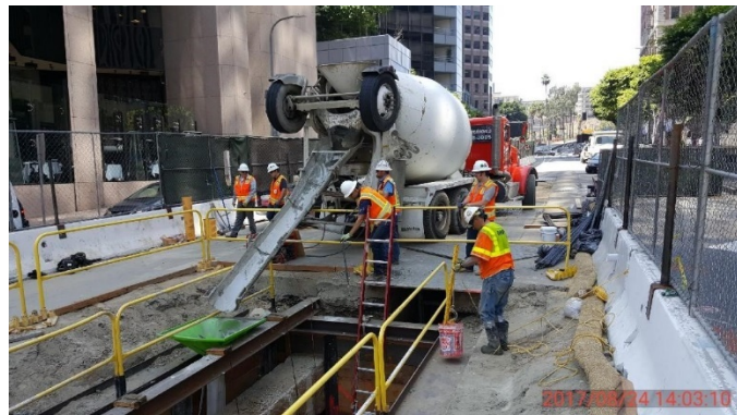
Concrete pour for Vault 805 on Flower Street
