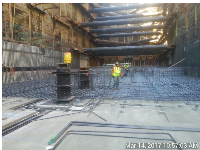
Installation of rebar bottom mat for Pour #2
