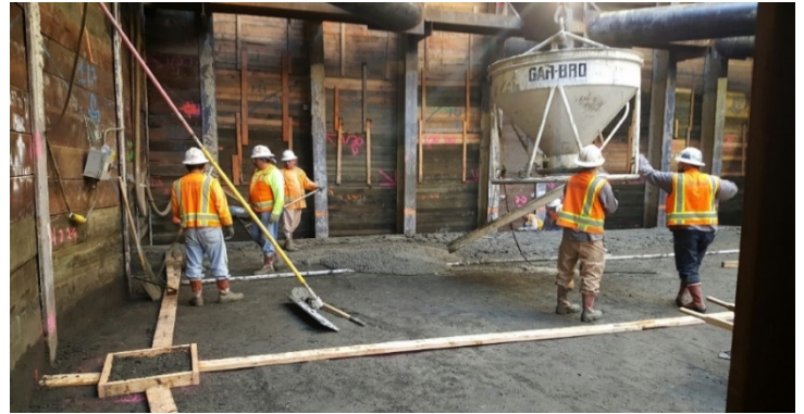
Protection Slab Pour at 2nd/Hope Station
