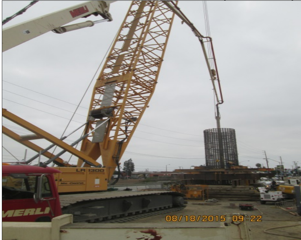
I-405 Underpass Bent 3 CIDH Concrete Pour.
