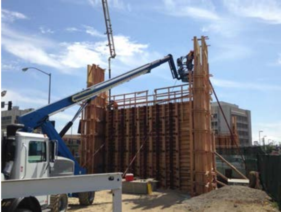
La Brea Abuttment 2 Stem Wall Pour.
