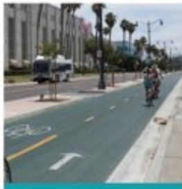
Vía para Bicicletas Separada de Doble Sentido de Clase IV
