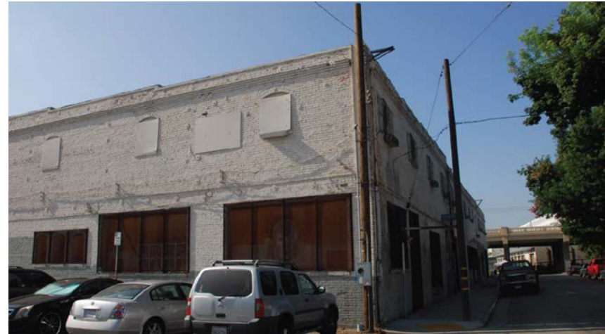
Citizen's Warehouse/Lysle Storage Company ビルディングのプロジェクトが提案される以前の北側と西側の外観の景色 出典: TY Lin International, 2018.
