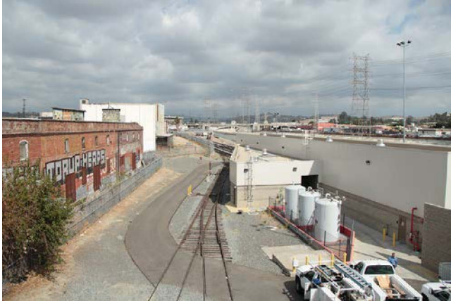
Vista de la propiedad, al norte del puente de 1 st Street
