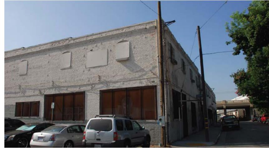
Vista del norte y oeste de las fachadas del edificio Citizen's Warehouse/Lysle Storage Company antes del proyecto propuesto. Fuente: TY Lin International, 2018.
