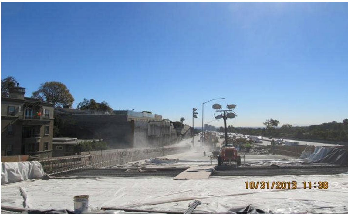
Bridge 14 Top Deck Pour.
