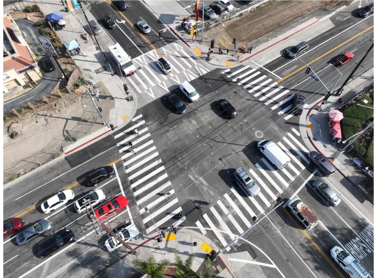
Vermont Av Intersection Raised Crosswalk
