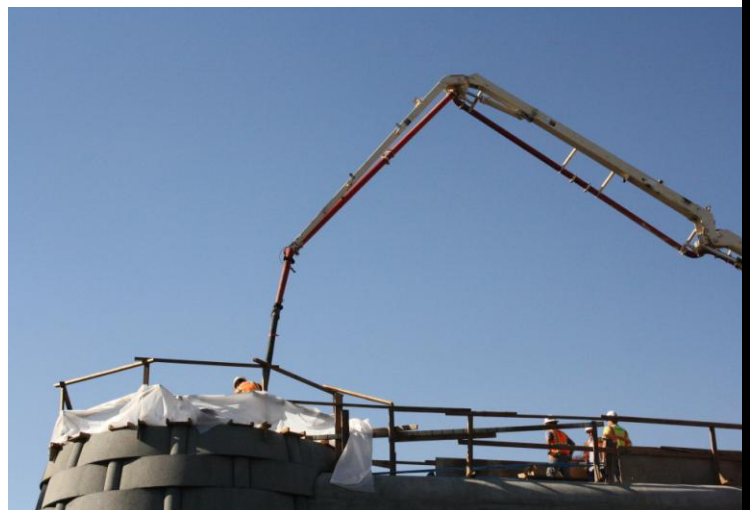
Concrete pour at south basket
