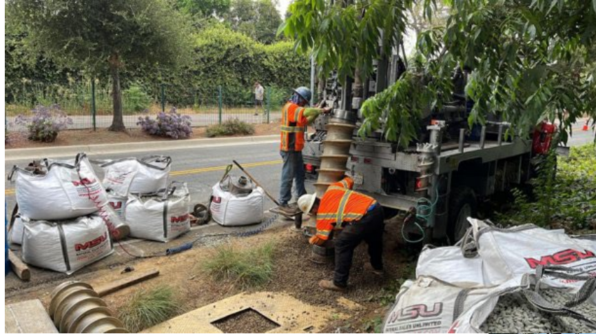
Pruebas de infiltración geotécnica
