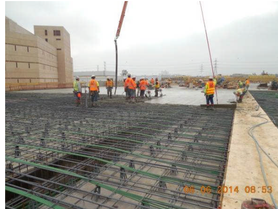
Concrete placement at roof level pour Deck # 17.
