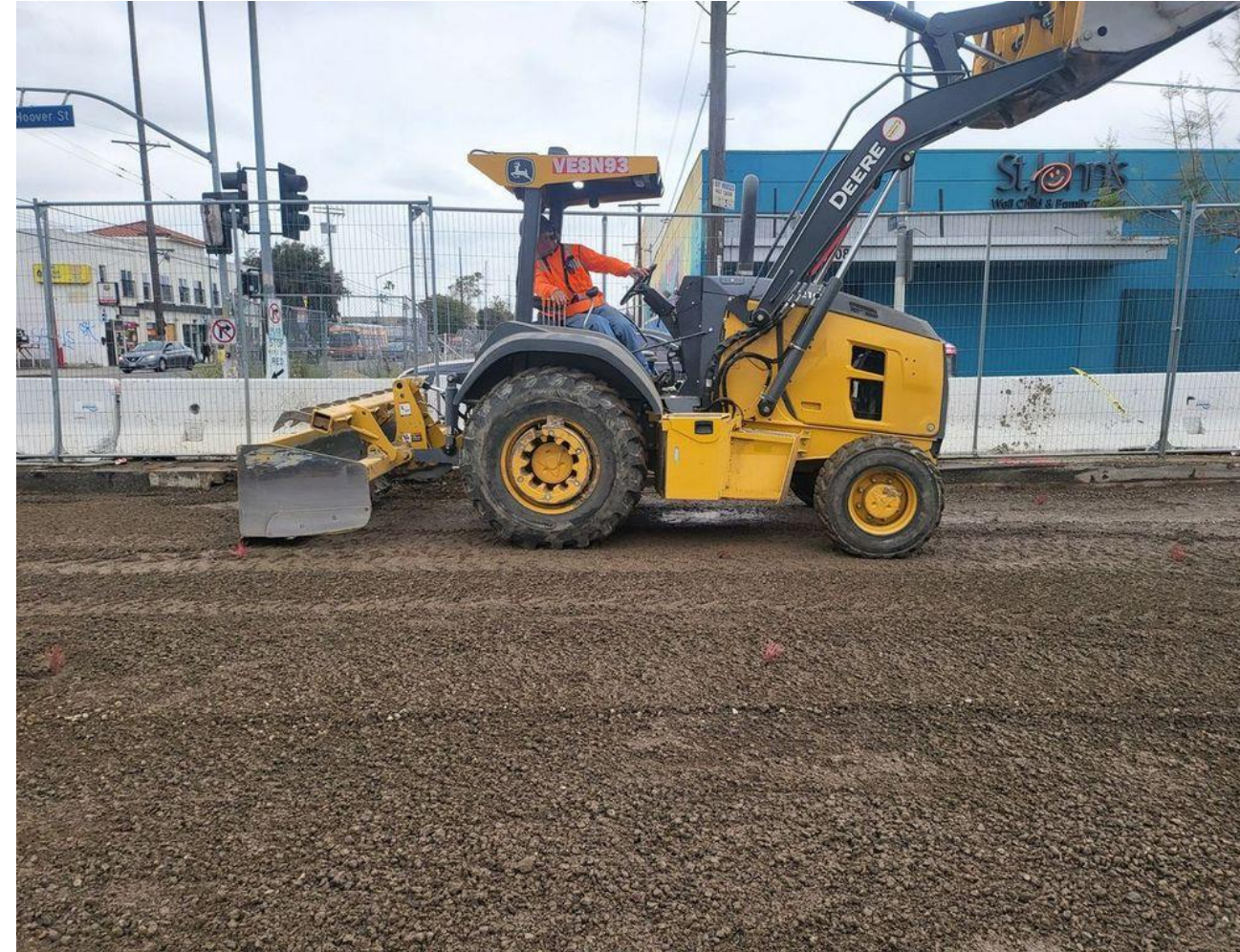
Sub-grading Slauson Av and Hoover St
