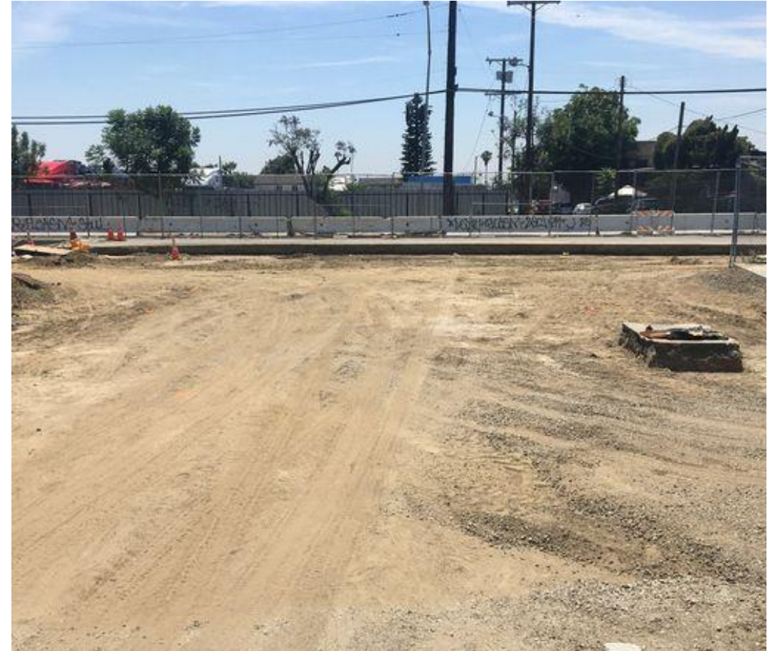
Towne Av Intersection Improvement Work
