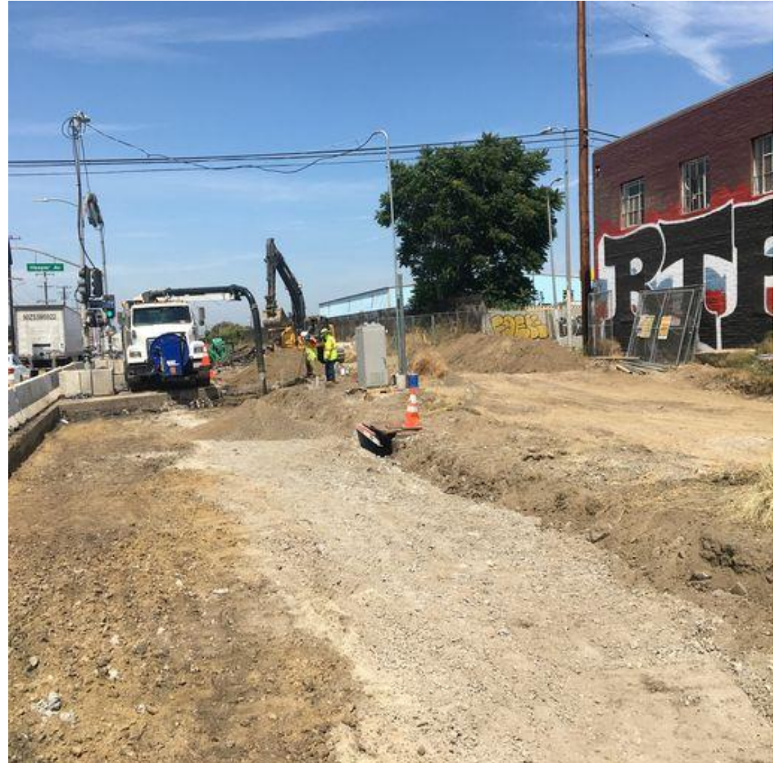
Hooper Av Intersection Improvement Work
