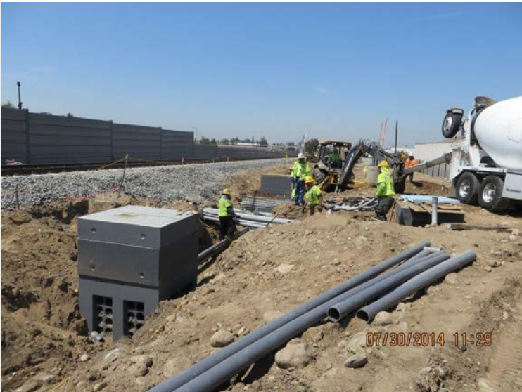
Segment 4: Virginia TPSS - Conduit Installation
