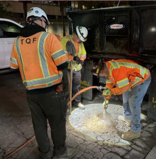
Se están realizando trabajos de excavación
