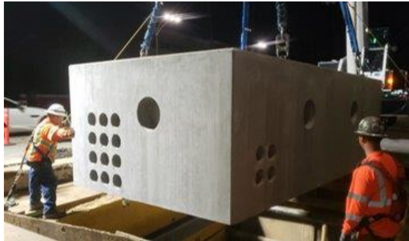
Instalación de bóveda de LADWP a lo largo de Van Nuys Blvd
