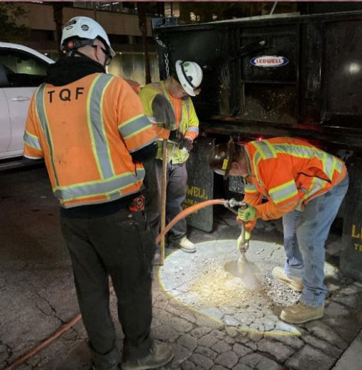
Actividades de obras de excavación de pozos
