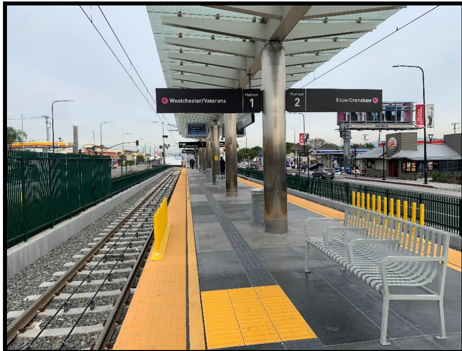
Estación Hyde Park de la Línea K del Metro
