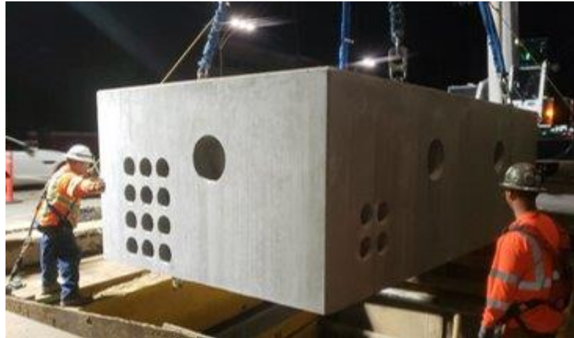
Instalación de la bóveda de LADWP a lo largo de Van Nuys Blvd.
