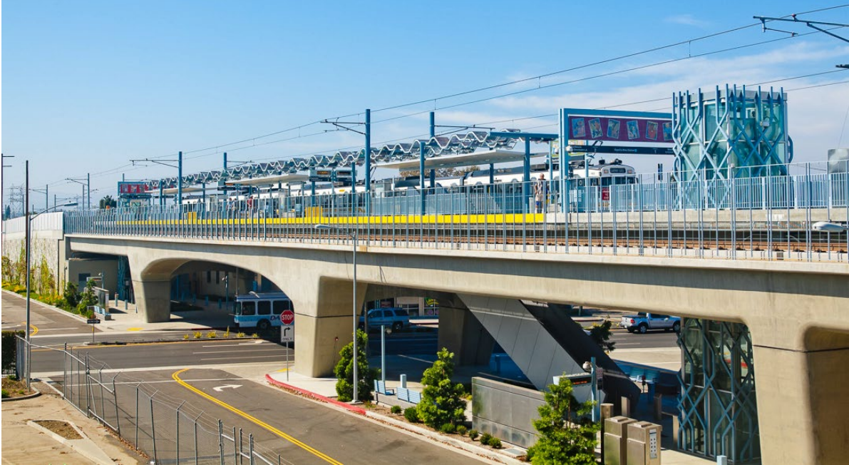
Línea E de Metro – Estación de La Brea
