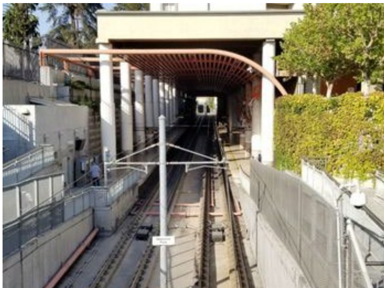
Estación de Memorial Park Ciudad de Pasadena
