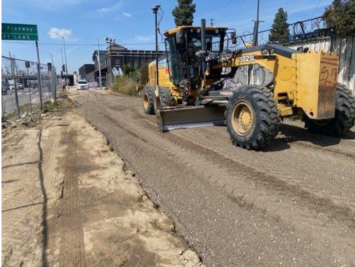
Fine Grading Metro Right of Way along Slauson Av
