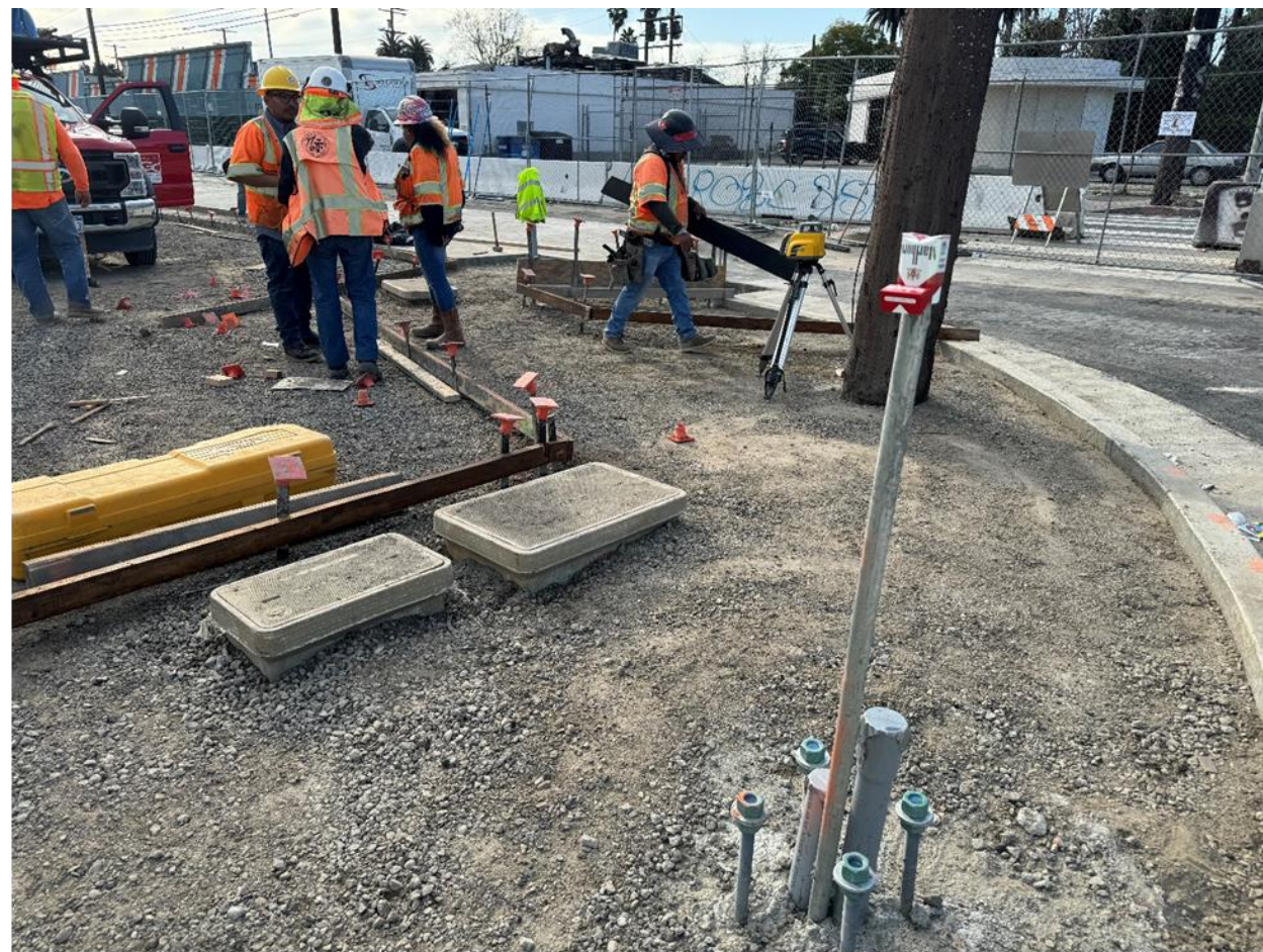
ADA Ramp construction at Normandie Av
