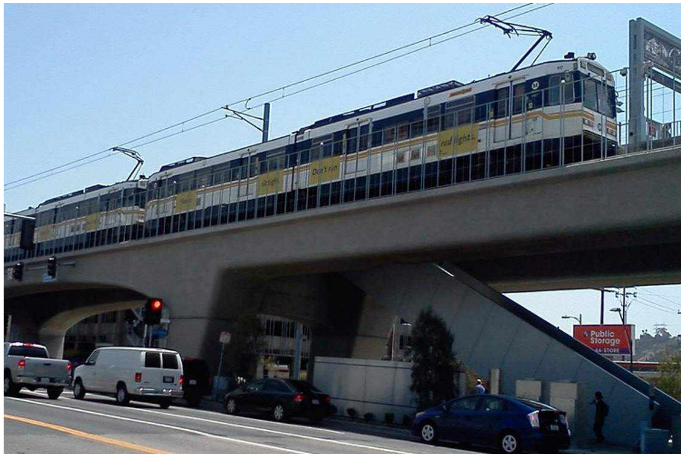
高架: Expo Line – La Cienega
