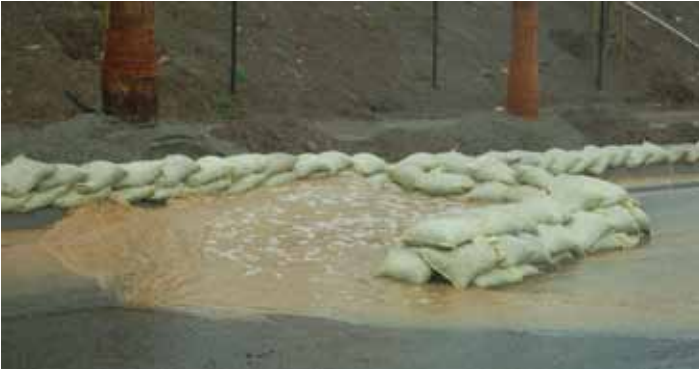
Kiểm soát dòng chảy nước mưa trong quá trình xây dựng đặc biệt quan trọng để duy trì chất lượng nước trong khu vực nghiên cứu.
