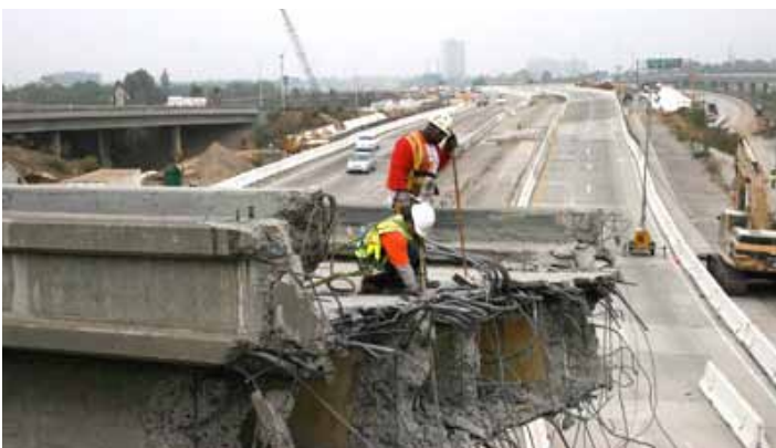
Hoạt động xây dựng có thể tạo ra chất thải độc hại sẽ được xử lý tại cơ sở xử lý thích hợp.
