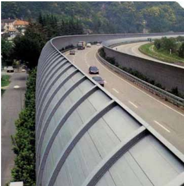
제안된 대안 6A, 6B, 6C의 화물 통행로는 스위스 Bellinzona에 설치된 것과 유사한 방음벽 및 화면벽을 포함할 수 있습니다.
