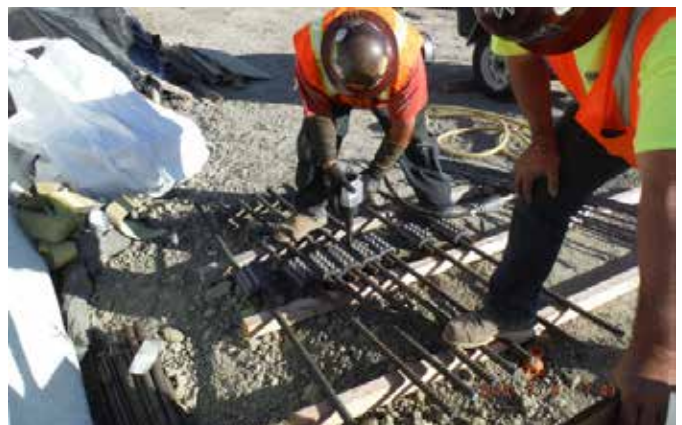
Kết quả hoạt động xây dựng tạo ra nhiều tác động ngắn hạn, đặc biệt là chất lượng không khí, tiếng ồn và cảnh quang. Một chương trình mở rộng về các biện pháp giảm thiểu xây dựng sẽ được thực hiện cho bất kỳ giải pháp xây dựng nào.
