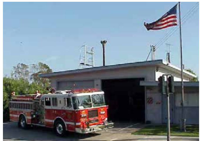
Trạm Cứu Hỏa Số 4 ở thành phố Vernon sẽ phải di dời theo cả hai giải pháp thay thế I-710.
