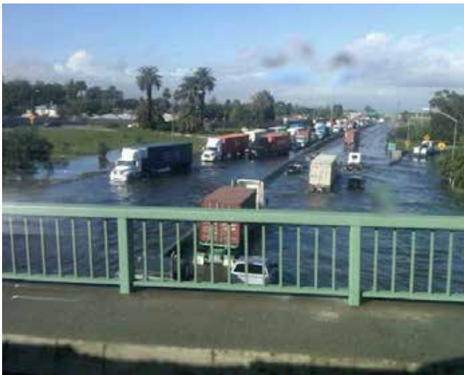
Tất cả các giải pháp thay thế xây dựng bao gồm cải tiến hệ thống thoát nước đường cao tốc.
