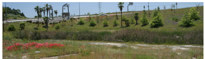
Isang tampok na bioswale na pagdadalisay sa umaagos na tubig-ulan.
