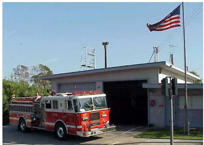
La estación de bomberos No. 4 de la Ciudad de Vernon requeriría ser reubicada según todas las alternativas de construcción del corredor I-710.
