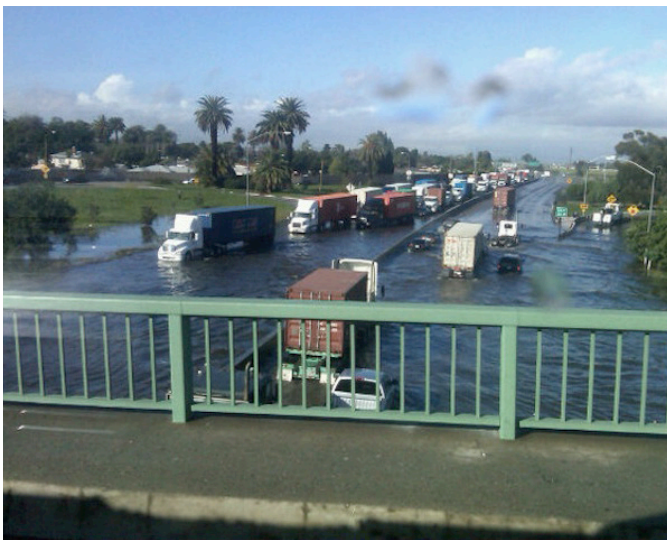
Todas las alternativas de construcción incluyen mejoras al sistema de desagüe de la autopista.
