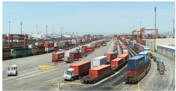
La I-710 proporciona un enlace crítico para el comercio interestatal entre los puertos de la Bahía de San Pedro, los patios ferroviarios de la BNSF y la UP y el resto del país.
