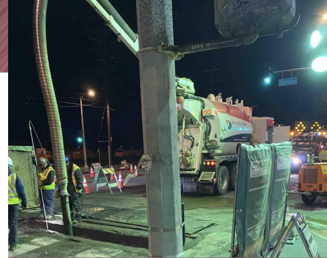
Pothole/slot trench work activity at Van Nuys Bl & Telfair Av
