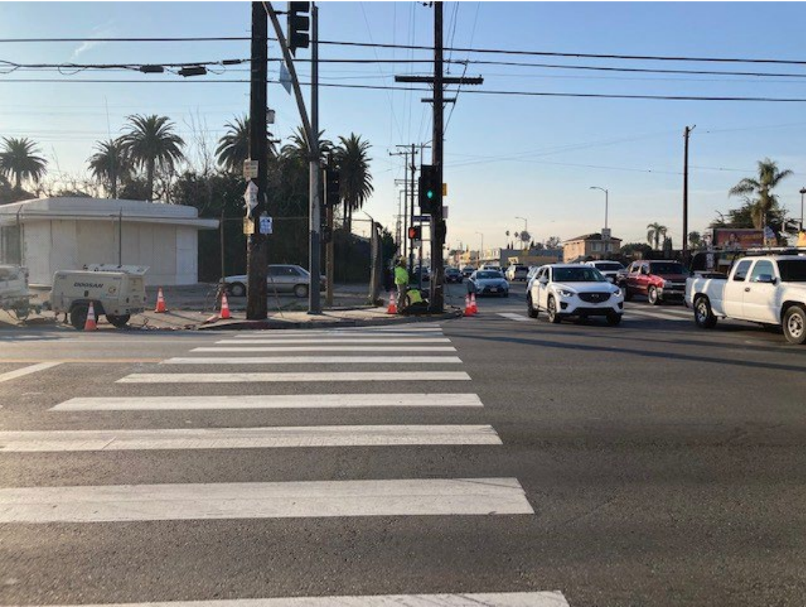
Normandie Av and Slauson Av potholing
