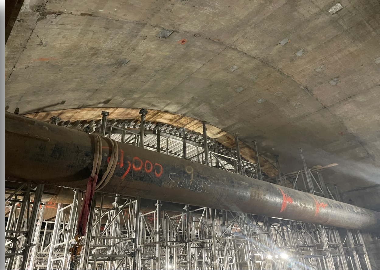
Station Roof Concrete Pour complete
