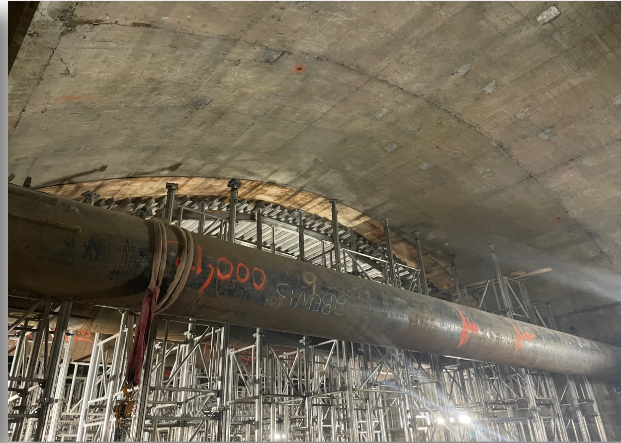
Station Roof Concrete Pour complete
