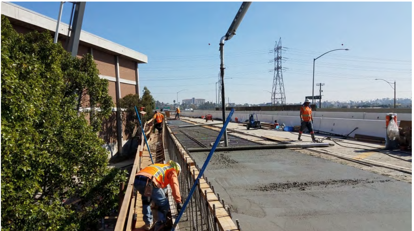
Frame 4 Left Deck Pour.
