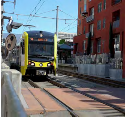
Postes del Sistema de Catenaria Aérea
