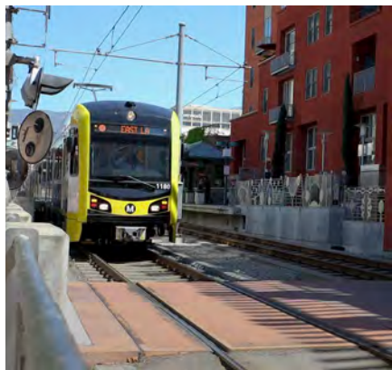
架空電車線のポール
