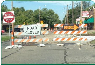
Barricades & Detour Signs
