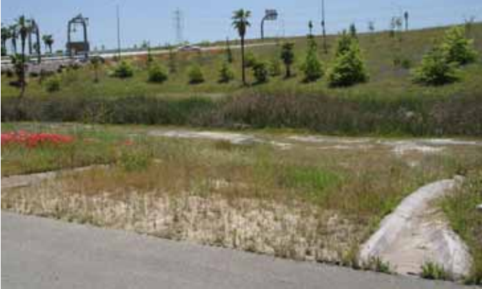
Una característica de canalización de las aguas de escorrentías provenientes de riachuelos urbanos.
