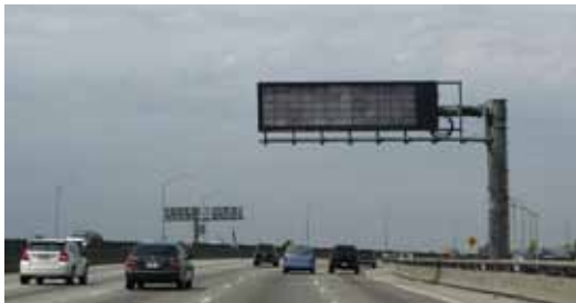
Se añadiría señalización adicional de mensajes intercambiables para proporcionar información crítica a los motoristas.
