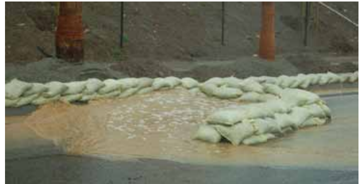
El control de las escorrentías pluviales durante la construcción es crítico para mantener la calidad del agua en el Área de Estudio.
