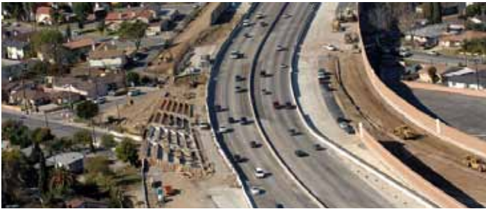
La construcción de cualquiera de las alternativas de construcción será una empresa de envergadura. Esta foto muestra un proyecto de ensanchamiento de una autopista de la SR-22 en Orange County.
