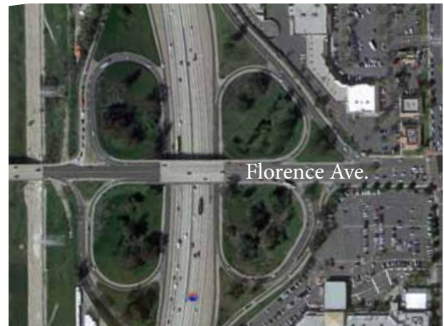
Los intercambios viales de tipo "trébol" construidos en los años 50 no tienen la capacidad para manejar el volumen de tráfico actual.
