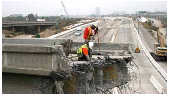
La construcción del proyecto puede crear desechos peligrosos, los cuales pueden ser eliminados en instalaciones apropiadas para desechos.
