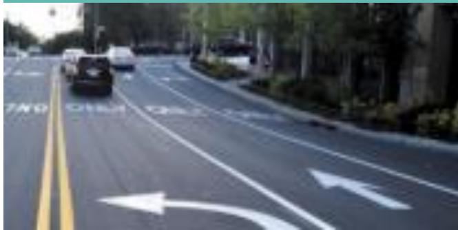
Cariles para dar vuelta y otras características de diseño para reducir las líneas de tráfico en las intersecciones congestionadas.
