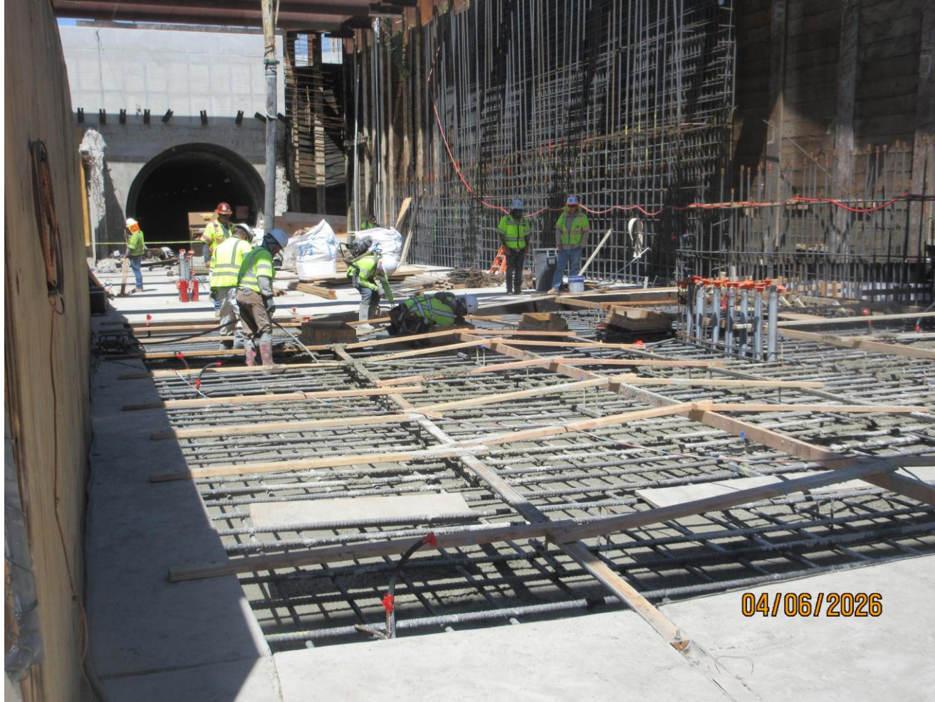
Track invert slab pour
