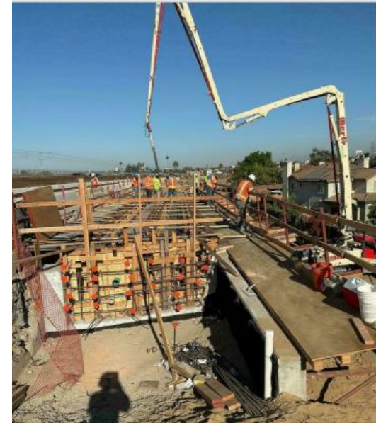
Yukon Av Underpass Reconstruction
